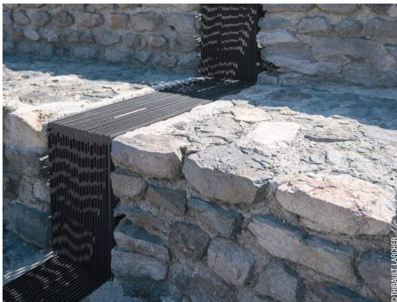
L'écoulement des eaux se fera plus facilement, réglant ainsi les problèmes d'infiltration.
