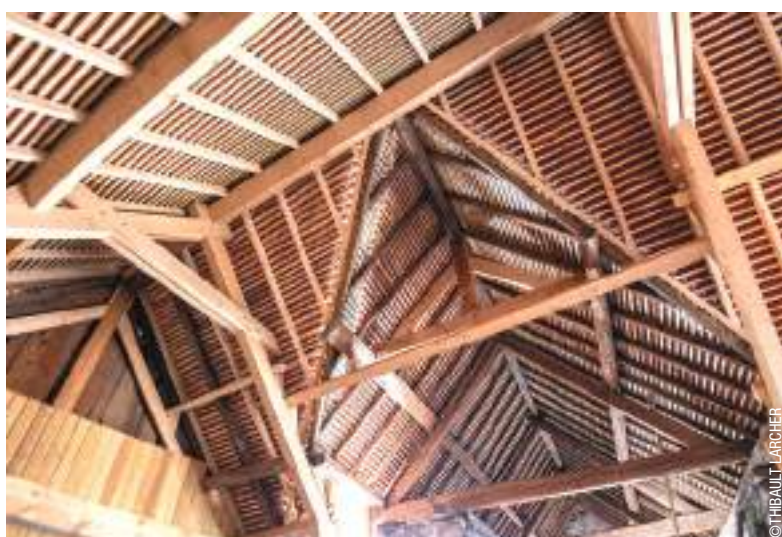
Huit mois ont été nécessaires pour rénover la charpente de la Maison Bernard à Lalley.
