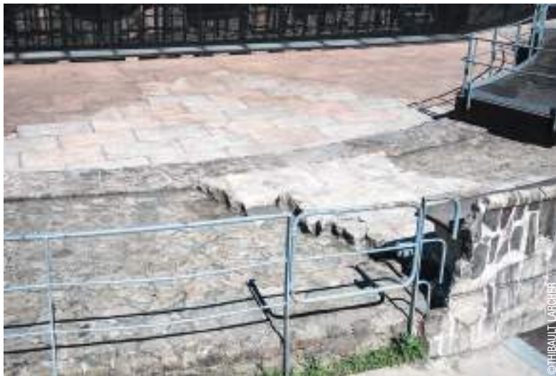
De nouveaux équipements sécurisent le site très fréquenté.
